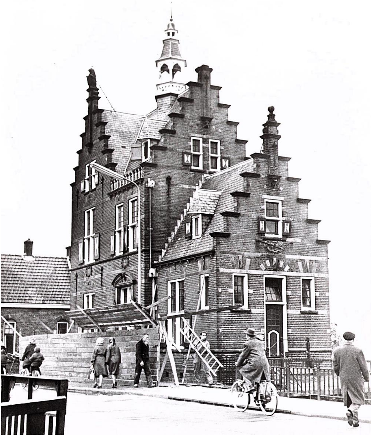
Een foto uit november 1962. De veiligheidsvoorbereidingen inzake de voorgenomen sloop van het Havenkantoor zijn begonnen. Onomkeerbaar en alle protesten ten spijt, het markante en geliefde gebouw zou definitief verdwijnen. De Havendienst moest tijdelijk uitwijken naar een andere locatie en het zicht op de stad vanuit de Voorzaan zou na de sloop een aantrekkelijke eye catcher kwijt zijn. En misschien draaide architect Doodhagen zich om in zijn graf.
