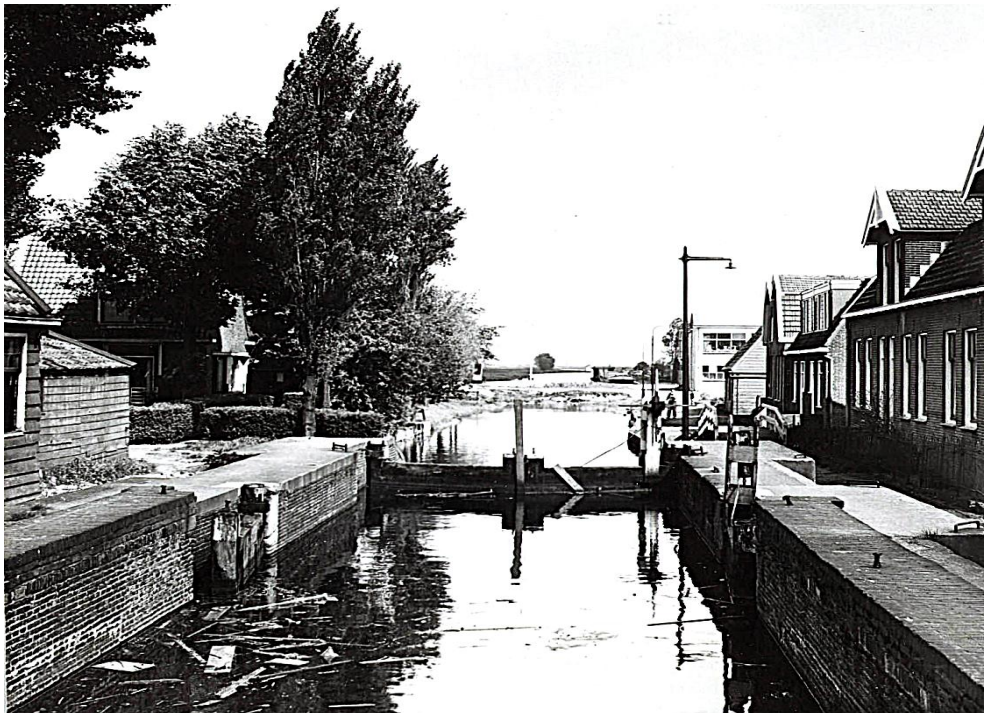
De Noordervaldeursluis met zicht op Noordervaldeurspad (rechts) en -Sloot begin jaren '50.
