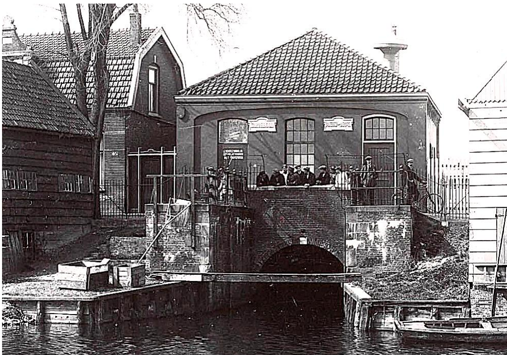
Gemaal Soeteboom in de Hogendijk gezien vanaf de Voorzaan. Foto plm. 1920
