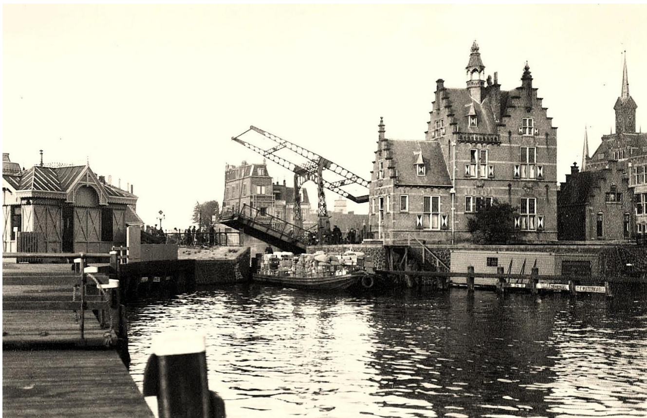
Een foto uit plm. 1927 van het Havenkantoor met links de pier waar o.a. de salonboten van de Alkmaar Packetrederij aanmeerden en achteraan het fraaie, houten wacht- en ticketlokaal. De 'kleine' Wilhelminabrug staat open om een motordekschuit te laten passeren
